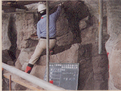
擬岩ブロック施工状況・Condition of pseudo-rock blocks
