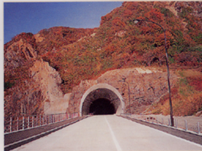
施工後の状況・After construction
